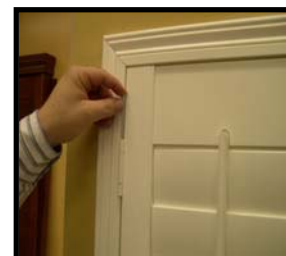
Insert hinge pin.
