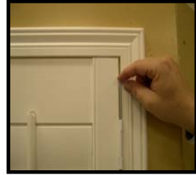
Insert hinge pin.
