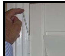
Insert hinge pin
