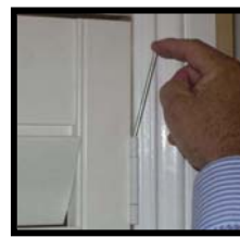
Insert hinge pin.
