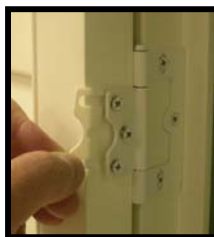
Insert hinge spacer
